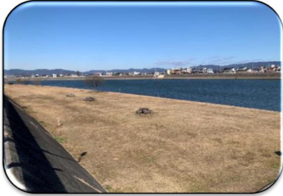
豊川左岸河川敷①
