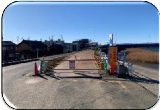
豊川左岸渡津橋東①
