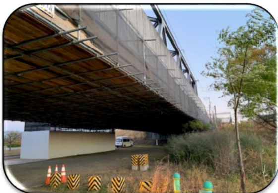
豊川左岸新幹線橋梁③
