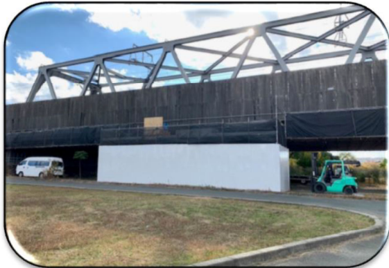
豊川左岸新幹線橋梁 ①
