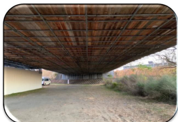
豊川左岸新幹線橋梁 ④
