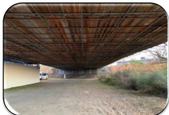
豊川左岸新幹線橋梁 ④
