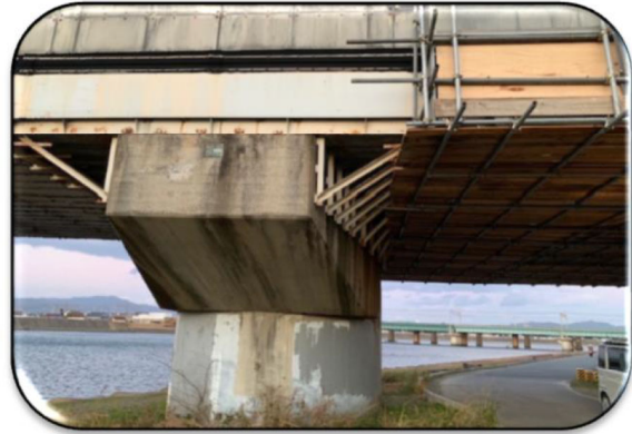
豊川左岸新幹線橋梁②
