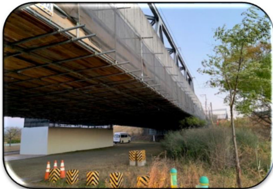
豊川左岸新幹線橋梁③
