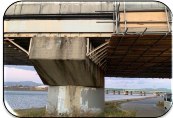
豊川左岸新幹線橋梁②
