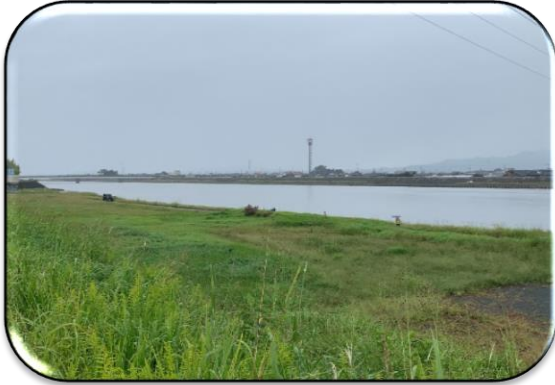
東海道新幹線西側 豊川左岸の状況①
