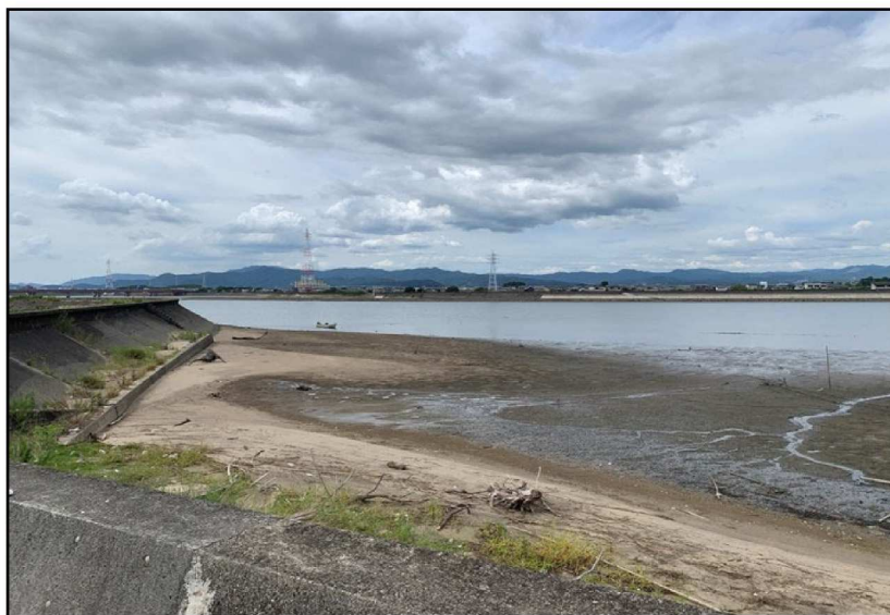
【高洲町地内の豊川左岸の状況②】
