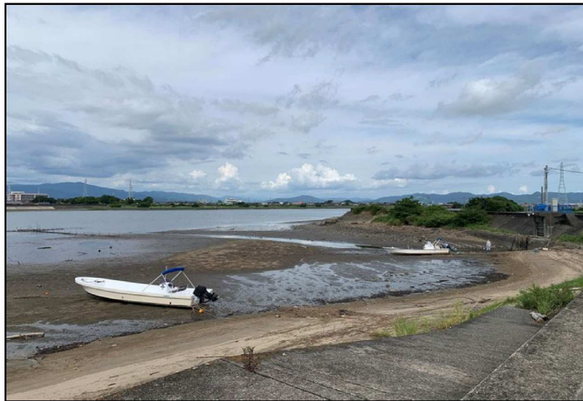
【高洲町地内の豊川左岸の状況①】
