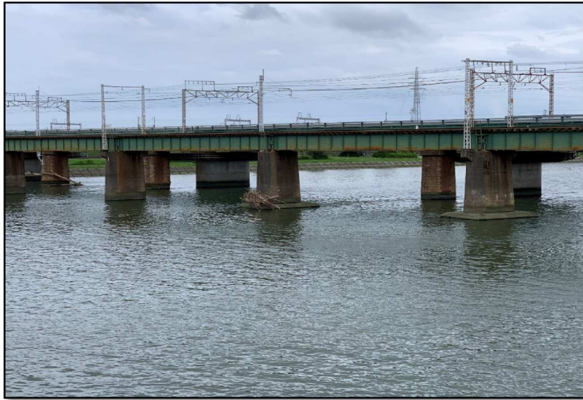
【名鉄本線橋脚の状況①】
