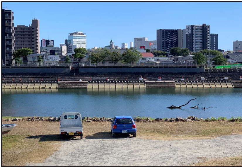
【はなび広場及び左岸の状況①】
