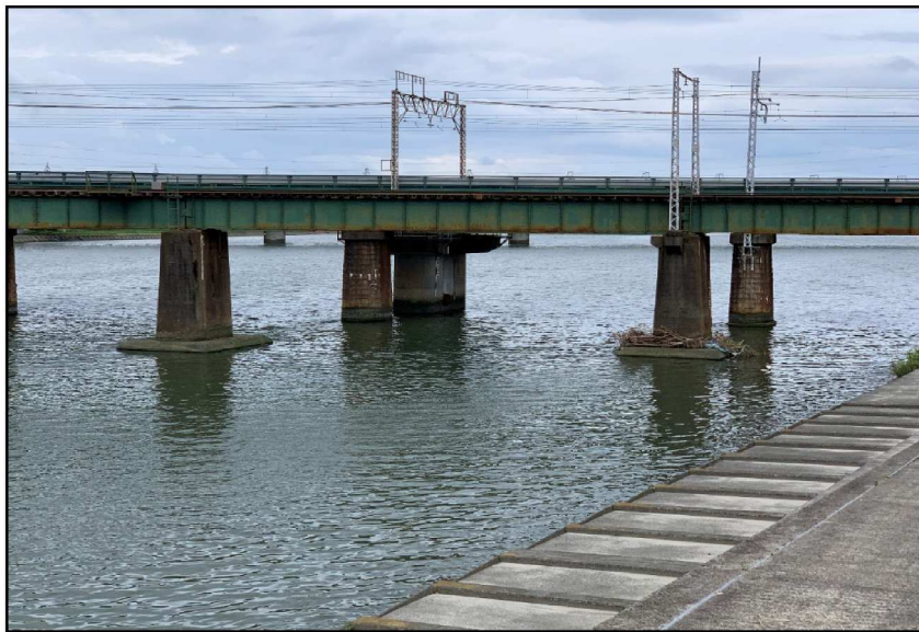
【名鉄本線橋脚の状況②】
