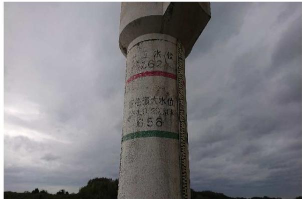
当古水位流量観測所の風景です。看板に氾濫注意水位 4.70m、計画水位 7.62、観測塔の壁面に既往最大水位 S34.9.27 洪水 6.56m と記されています。観測塔の壁面の表示は剥げてとても見にくくなっていますので、しっかりと書き直していただきたいものです。とはいえ、既往最大水位 S34.9.27 洪水 6.56m の記録は、豊川放水路完成の S40 以降破られていないので、塗り替える必要は無いのかも知れませんね。ただ、一昨年(2019年)の台風24号の時には、氾濫注意水位を超えて避難判断水位の 6.2m に迫ったのは記憶に新しいところです。川の水位と氾濫の危険性について、しっかりと注意喚起を要望します。
