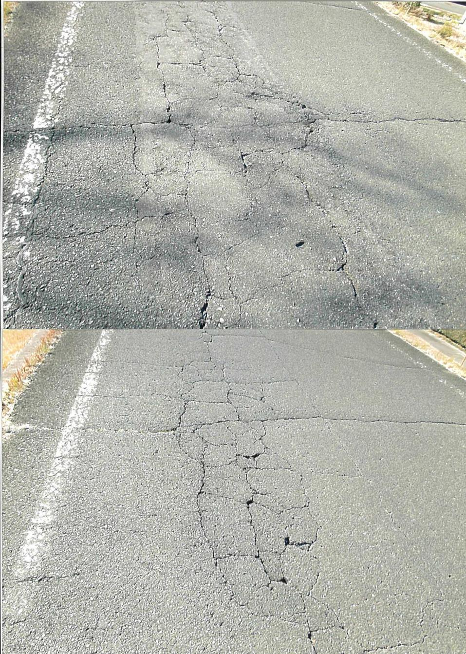
状況説明 = 19.8km 争前 横の車裂と共に縦の車裂が細かく連続しています。
