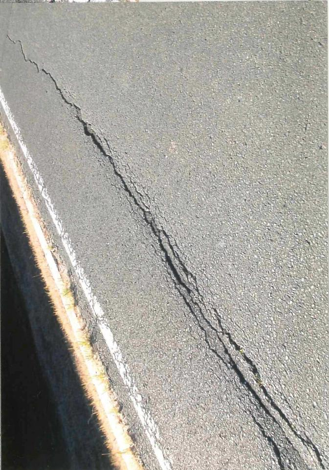
報告: 豊川左岸 20km附近(金沢橋南方)の堤防道路にて、道路東端より縦の軋裂が走り中央側より
