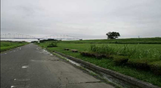
下流15km地点 右岸上流から
