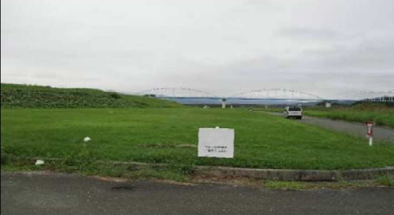
下流15km地点 右岸下流から
