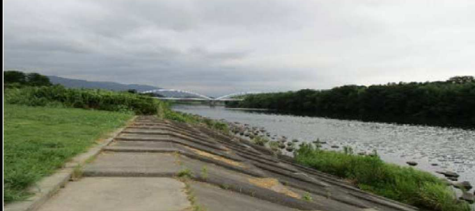
下流から25.5km地点 右岸 下流から
