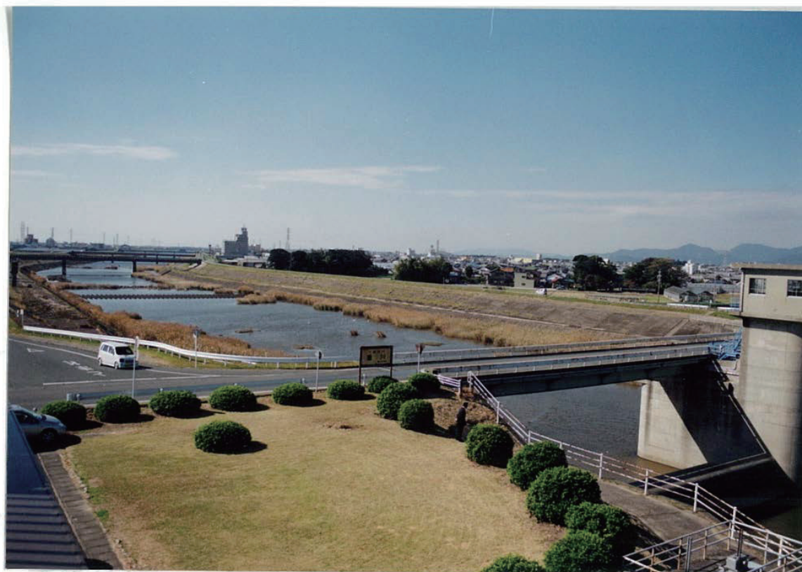
図2 豊川放水路のゲートから下流を望む
