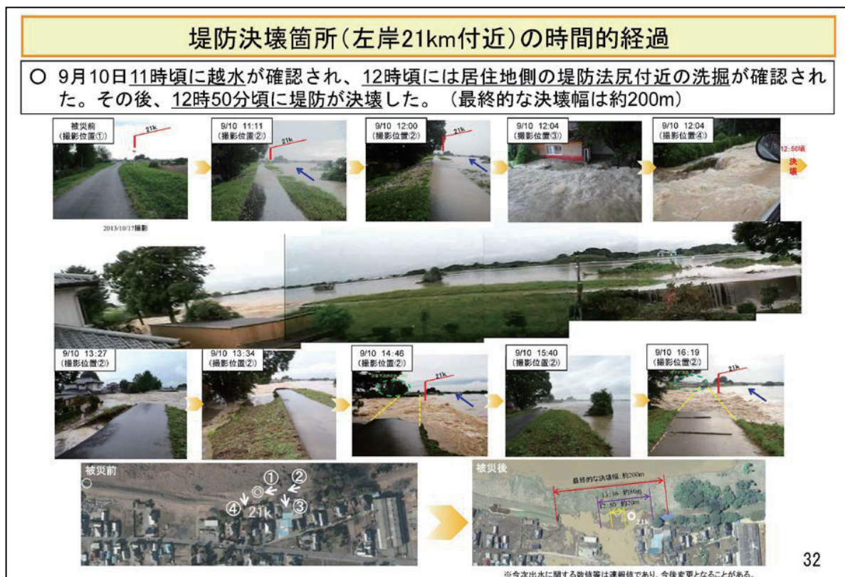
図21 堤防決壊箇所(左岸21km付近)の時間的経過
