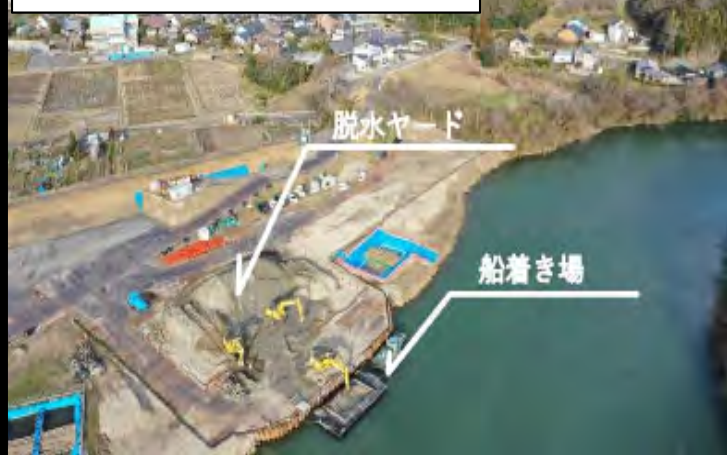
【揚土場状況】(竜宮橋下流左岸)
