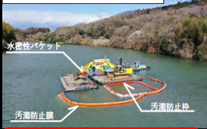
【掘削状況】 1日あたり最大約360m 3 を掘削
