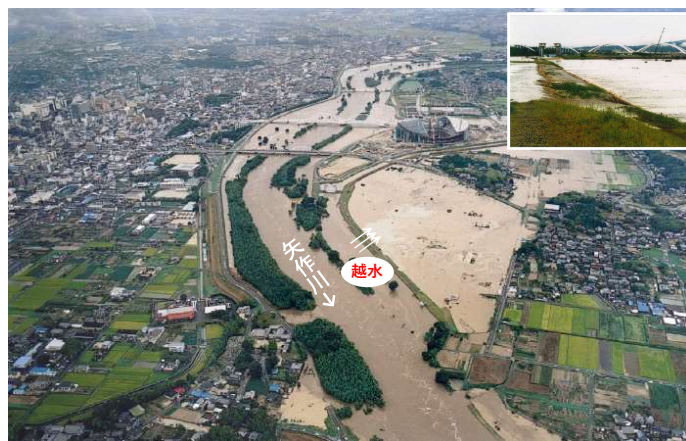
平成12年9月「東海豪雨(恵南豪雨)」の被害状況(豊田市森地区)
