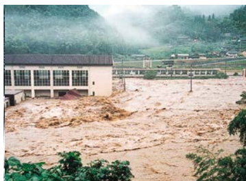
流出した幼稚園(豊田市小渡町)
