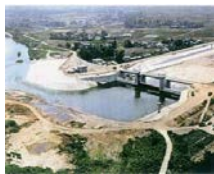
豊川放水路建設時の状況
