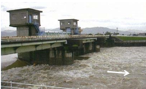
■ 豊川放水路の出水時の放水状況
