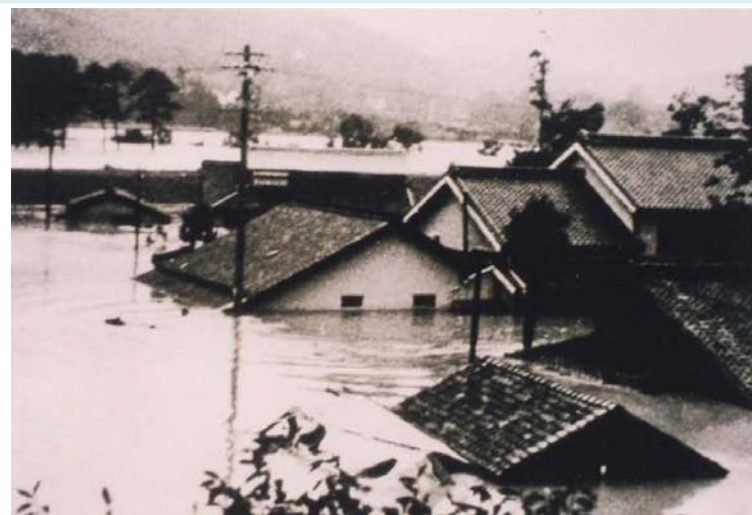
昭和43年8月浸水状況(新城市豊島)
