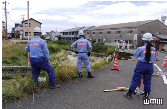
②復旧資材の提供 (袋詰め玉石112個 6/5 国より提供)
