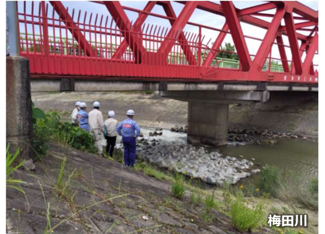
③増水した河川に対し今後すべきことについて、現地調査を実施し、対策について助言
