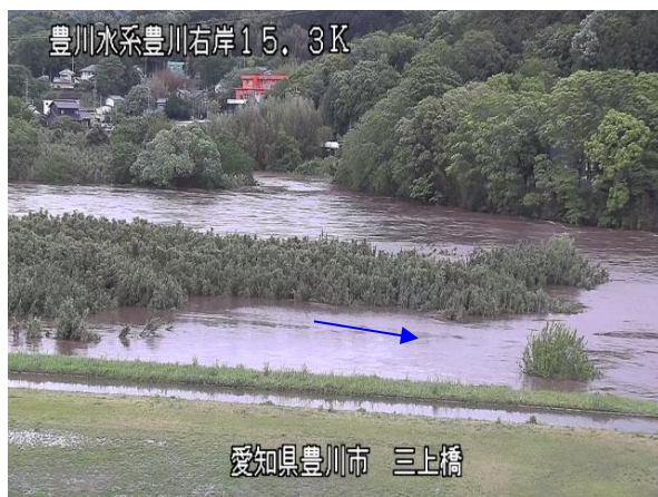
三上橋河道内状況(④)
