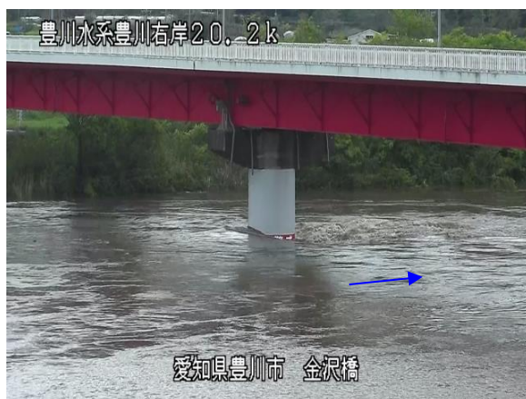
金沢橋河道内状況(⑤)
