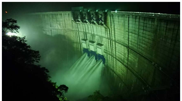
矢作ダムの放流状況(10月1日1時頃)
