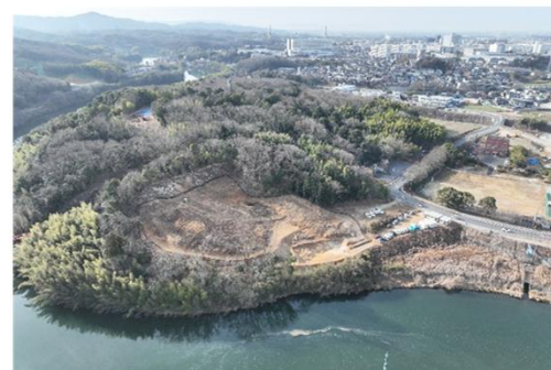
【R7伐採状況 R8.2月時点（上流より望む）】
