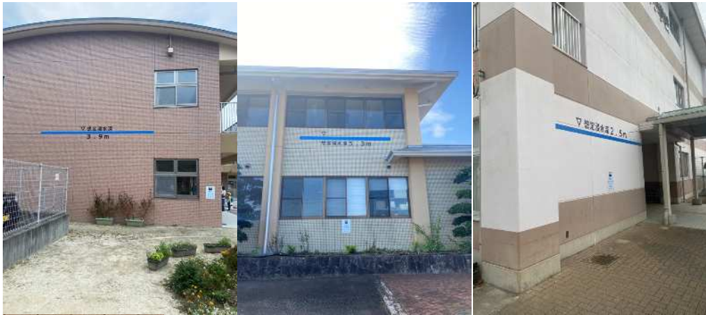
▲公共施設の壁面等に整備された浸水深の位置
