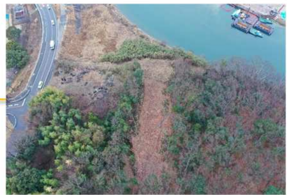
【③伐採後(上空から撮影)】
