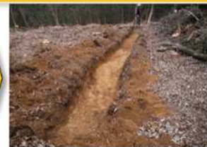
【⑤筋掘り完了後】
