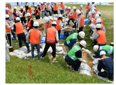
◆自治会・企業・学生による水防工法(月の輪工法) 2019年豊川・矢作川連合総合水防演習・広域連携防災訓練
