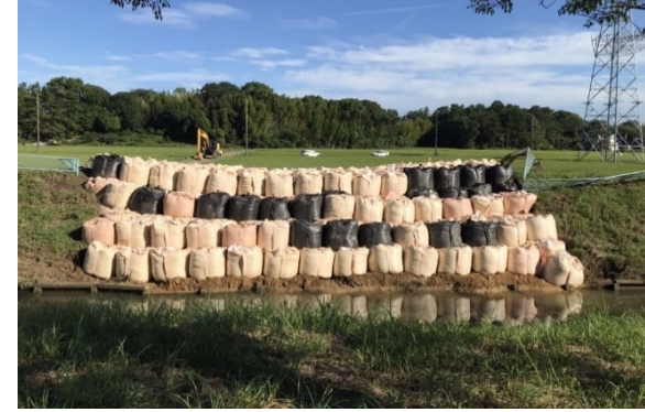
応急復旧完了 (7月28日AM7時20分)
