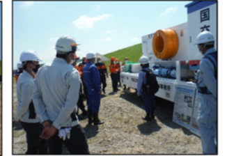
矢作川下流部堤防維持管理修繕工事 (木村建設(株))
