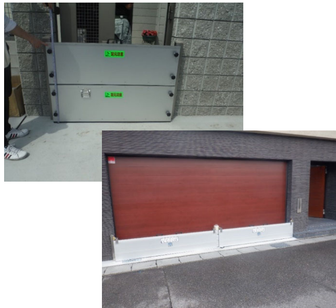
■ 止水板設置状況
