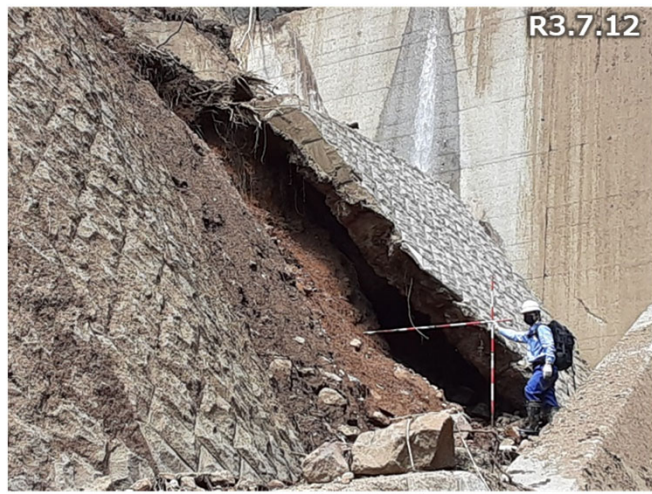
砂防施設の被災状況調査
