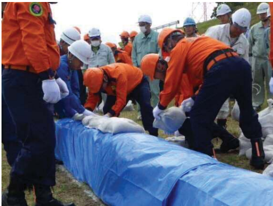
工法実施の様子
