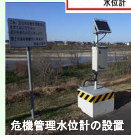
水位計の設置
