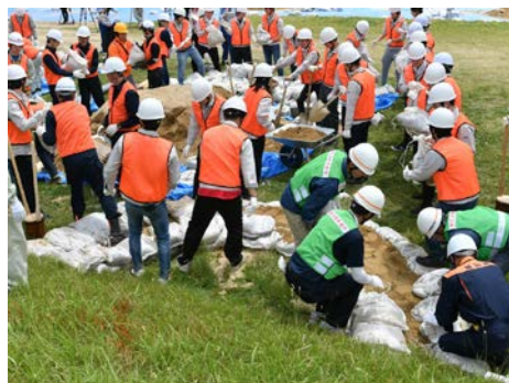
自治会・企業・学生による水防工法 (月の輪工法)
