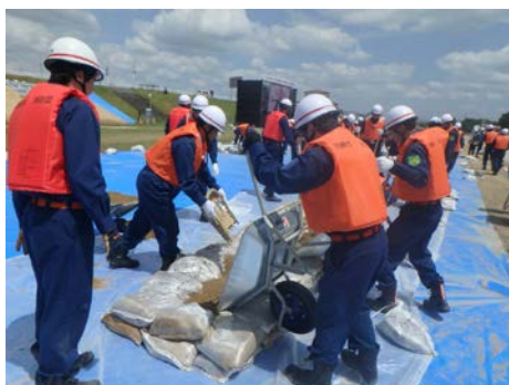
消防団による水防工法 (積み土のう工)
