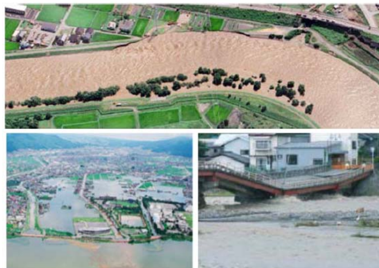
天竜川上流：近年の洪水による堤防決壊事例 【平成18年7月豪雨】堤防決壊に伴う浸水被害状況 出典：天竜川上流河川事務所HP
