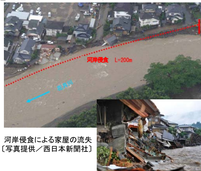
堤防決壊に伴う氾濫流により木造家屋が倒壊した状況
