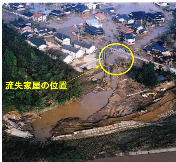
堤防決壊に伴う氾濫流により木造家屋が倒壊した状況
