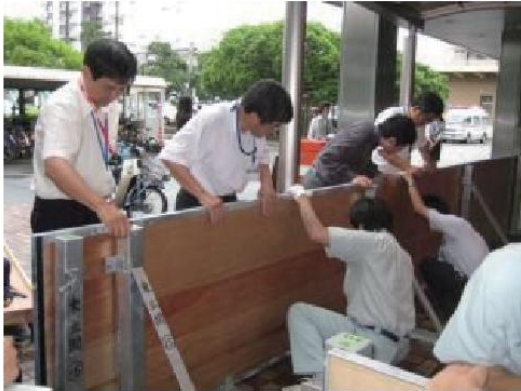
▲止水板設置訓練の実施 【国土交通省 浸水被害防止に向けた取組事例集H29.8】
