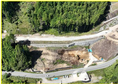
③国道257号4号橋上部工
