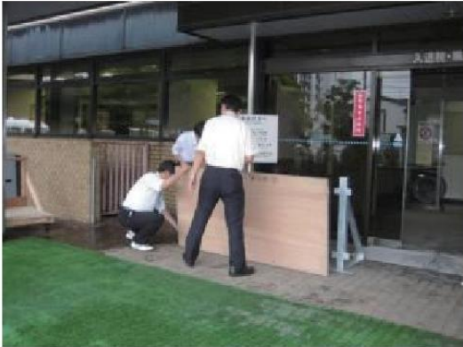
▲止水板設置訓練の実施 【国土交通省 浸水被害防止に向けた取組事例集H29.8】
