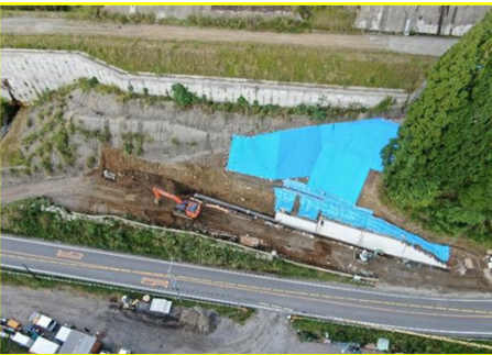
④国道257号1号橋上部工
