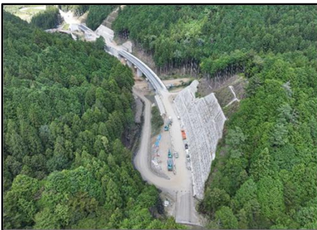
設楽根羽線1号トンネルから4号橋
