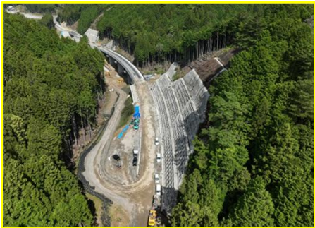
②瀬戸設楽線3号橋左岸下部工
