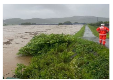
津谷地区の浸水被害 堤防の監視
