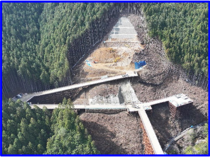
②瀬戸設楽線3号橋左岸下部工
