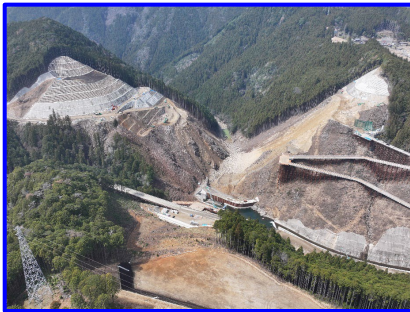
①ダム本体施工箇所(上流側より撮影)
