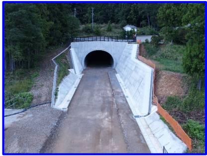
⑤瀬戸設楽線4号トンネル
