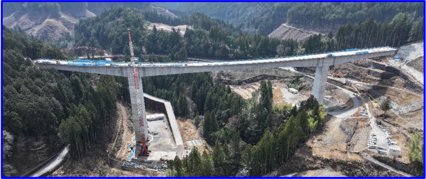
③国道257号4号橋上部工
