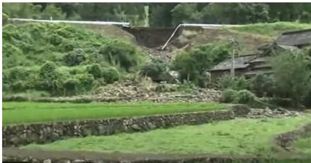
東峰村 バス専用道路の崩落
