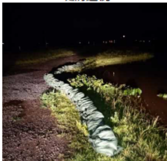
岩木川左岸（野木地先） 積み土のう
