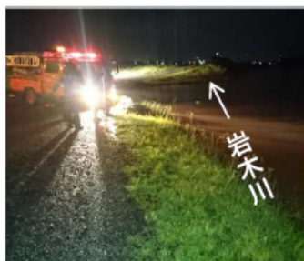
岩木川左岸（野木地先） 堤防巡視
