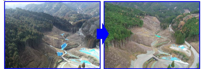
〈着手前〉 〈完成後〉
