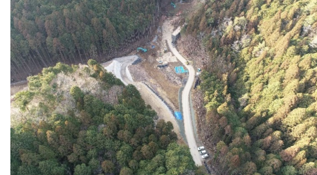
③付替県道設楽根羽線【小松地区】
