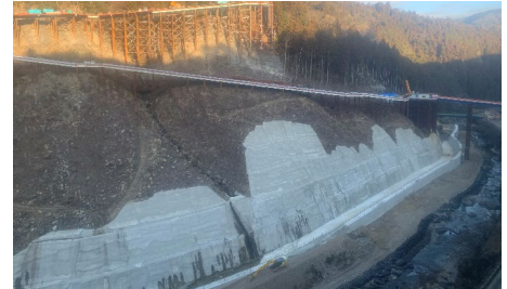
⑥河川切り直し水路【ダムサイト】
