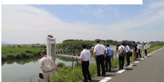
堤防とその周辺の点検確認
