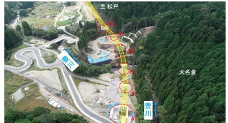
②付替県道瀬戸設楽線1号橋【大名倉地区】
