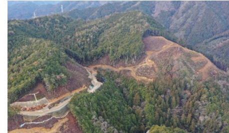
⑤基礎掘削(左岸頂部掘削)【ダムサイト】
