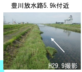
(ヨシ原創出後の豊川放水路) H29.9撮影
