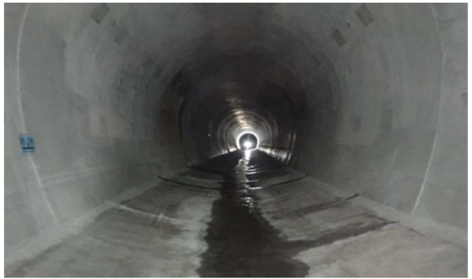
令和元年1月: 転流工コンクリート打設完了
