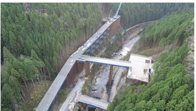
令和元年1月: 工事用道路の施工状況
