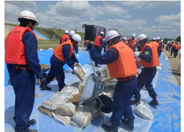
消防団による水防工法(積み土のう工)
