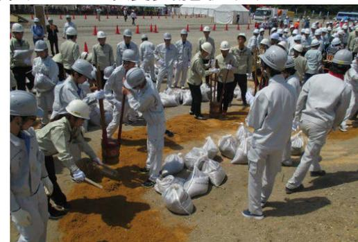
大学生による水防工法(月輪工)
