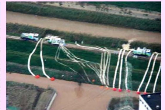
排水ポンプ車による緊急排水 (兵庫県豊岡市)
