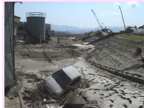
円山川の破堤による被害 (兵庫県豊岡市)
