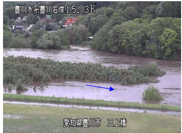
三上橋河道内状況(④)
