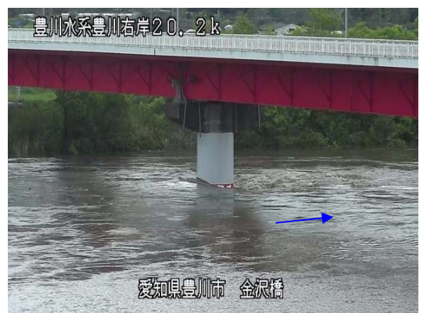
金沢橋河道内状況(⑤)
