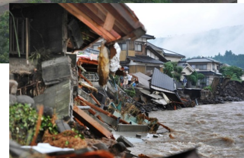
堤防決壊に伴う氾濫流により木造家屋が倒壊した状況
