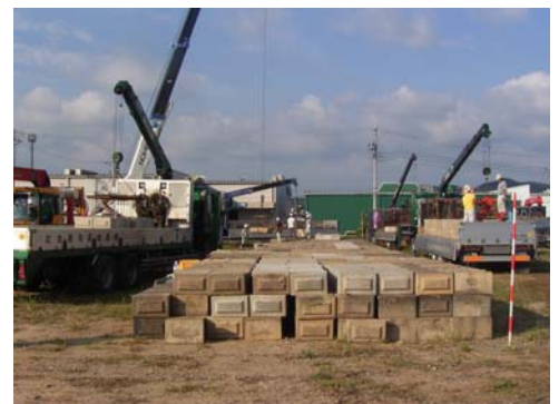
復旧資材の搬入
