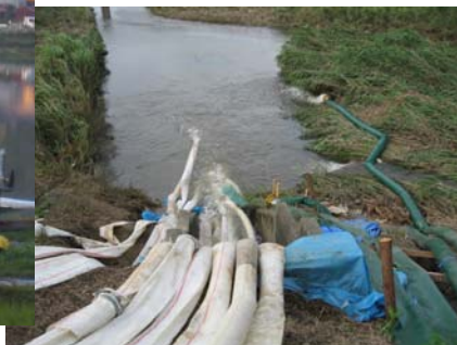
排水ポンプ車による排水状況
