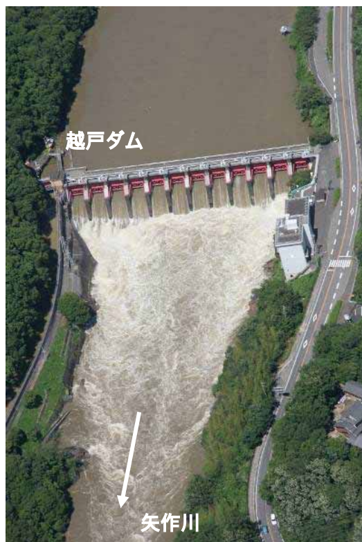
越戸ダム(中電)放流状況 平成19年7月15日 13:00頃
