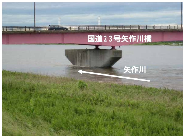
国道23号矢作川橋 平成19年7月15日 12:00頃 (ピーク時刻 11:00頃)
