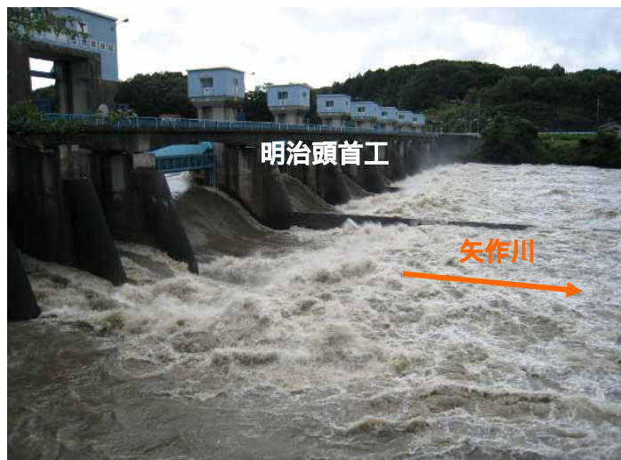
明治用水頭首工放流状況 平成19年7月15日 9:00頃 (ピーク時刻 9:00頃)
