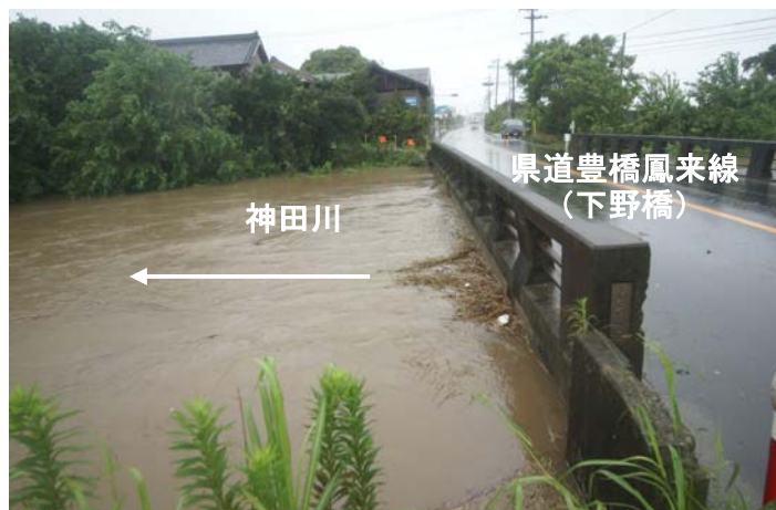
県道豊橋鳳来線(下野橋)の状況
