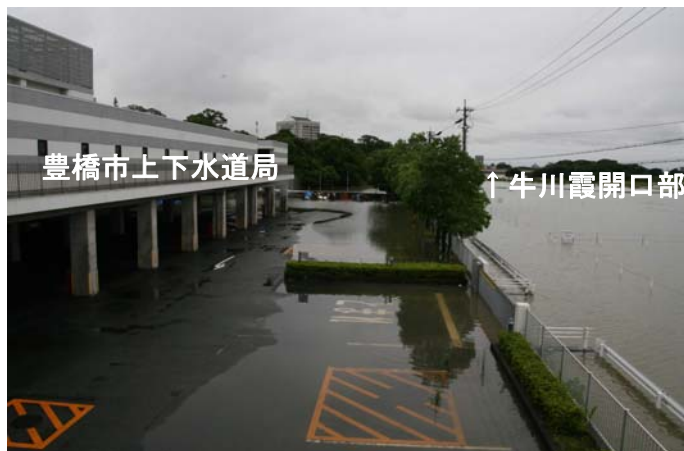
豊橋市上下水道局前の冠水状況
