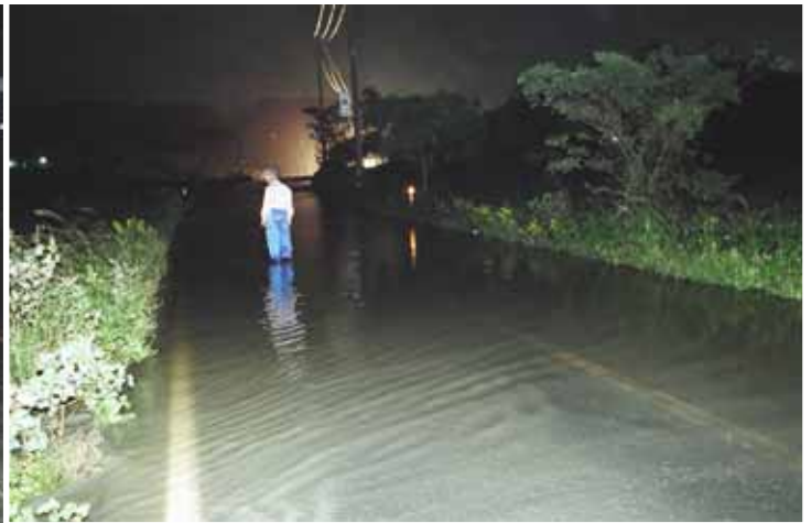
県道の冠水状況(通行止め)
