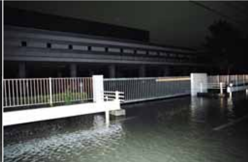
上下水道局前の冠水
