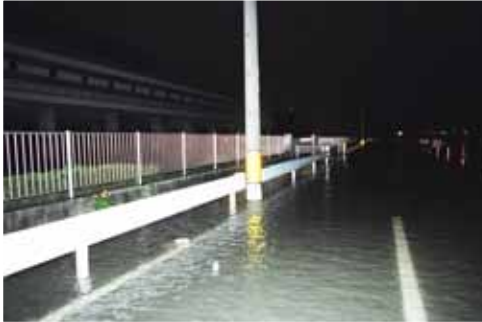
上下水道局前の道路の冠水
