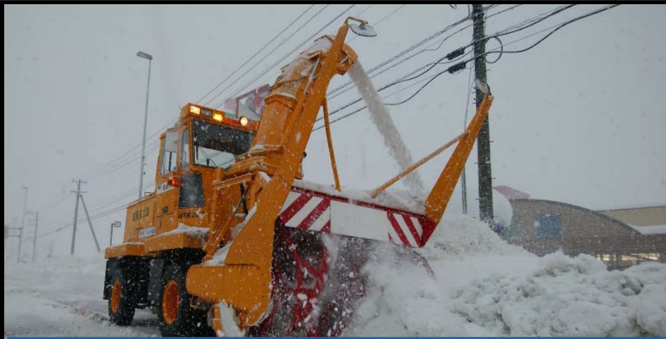
福井県福井市 ローリー除雪車の活動状況(2月8日)
