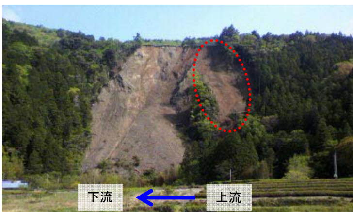
4月26日撮影 (25日22時13分上流側約30m拡大後)
