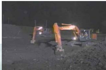
夜間の仮排水路掘削が可能となった
