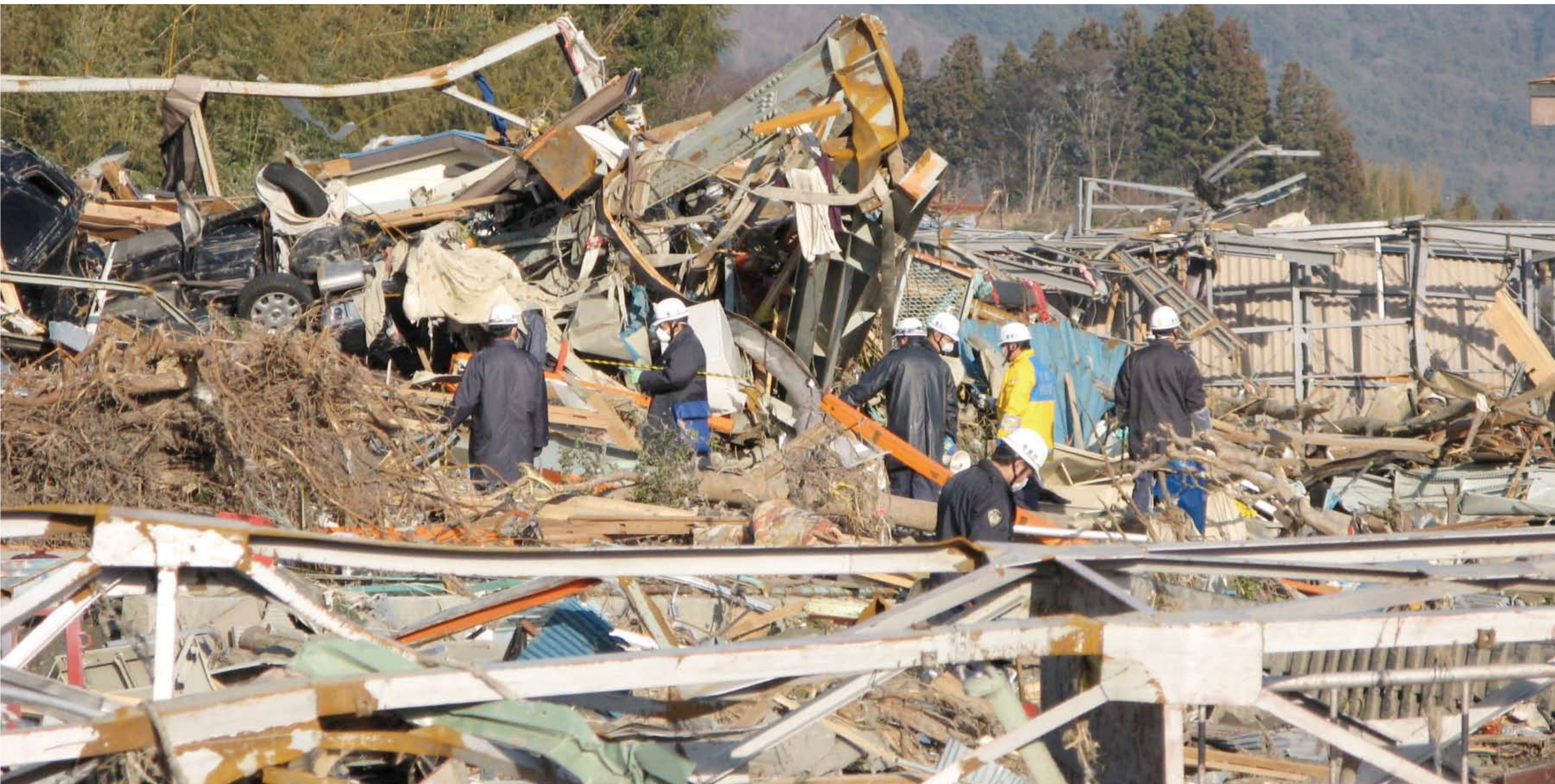
被災調査(岩手県陸前高田市)
